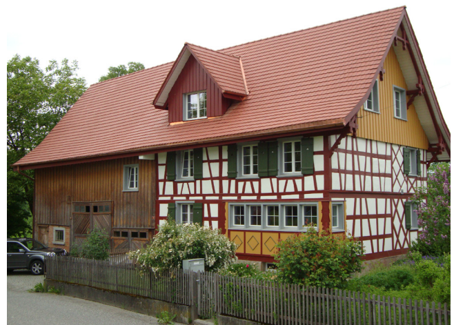
Energetisch saniertes, denkmalgeschütztes Bauernhaus, TG
