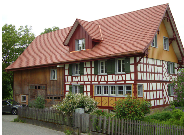
La ferme classée après l'assainissement global
