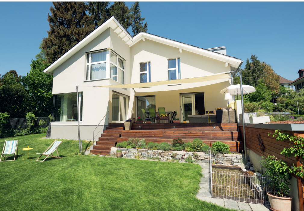
Das sanierte Einfamilienhaus aus den 1940er-Jahren.
